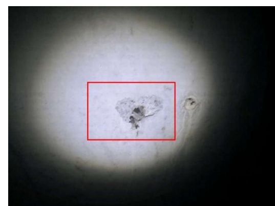
图 3-10: 湖洋 1 号大桥 (上行) 7-7-8 箱梁: 距右侧 2m 处, 梁顶剥落、掉角; 数量: 1 处, 长度: 0.3m, 宽度: 0.2m。
